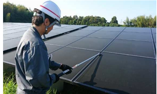
ソラメンテ-CiSアダプターでの点検
