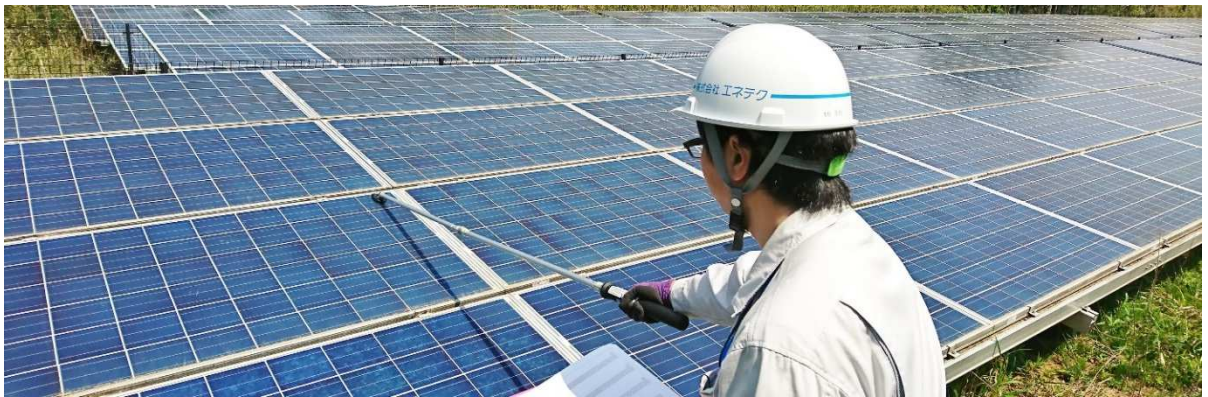
パネルチェッカー:ソラメンテ-IS(SI-200) クラスタ高抵抗化パネルを特定
