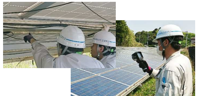
パネルチェッカー:ソラメンテ-IS(SI-200) クラスタ高抵抗化パネルを特定
