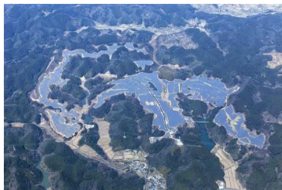
オリックス51M津メガソーラー発電所
