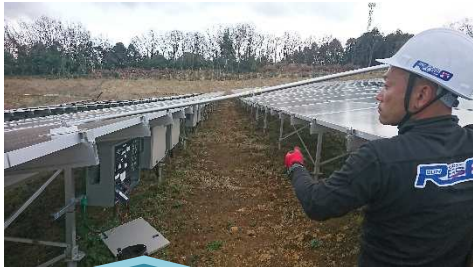
ケーブル断線箇所を効率よく特定 ストリングマップの作成
